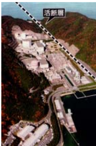
日本原電・敦賀原発の敷地内を走る「浦底断層」
