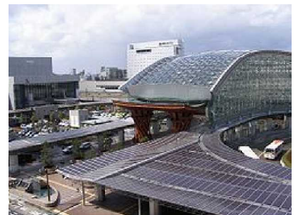
金沢駅東口もてなしドーム
